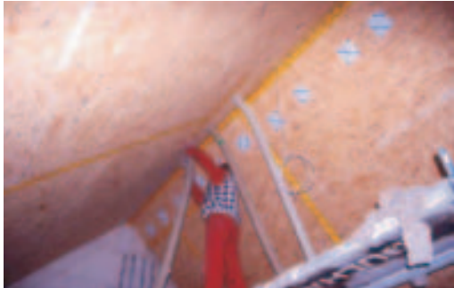
Bild 2: Einblasen der Zellulosedämmung
