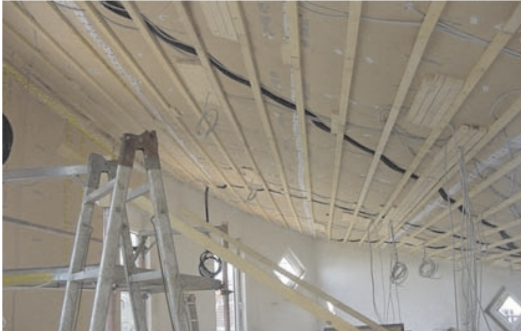
Bild 2: Innenansicht während der Bauphase
