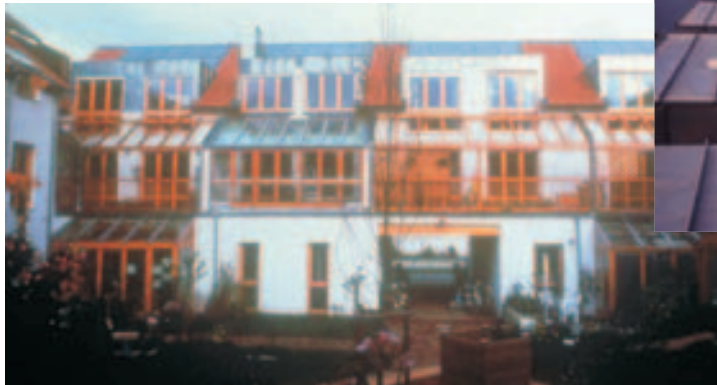
Bild 2: Gesamtansicht von innen
