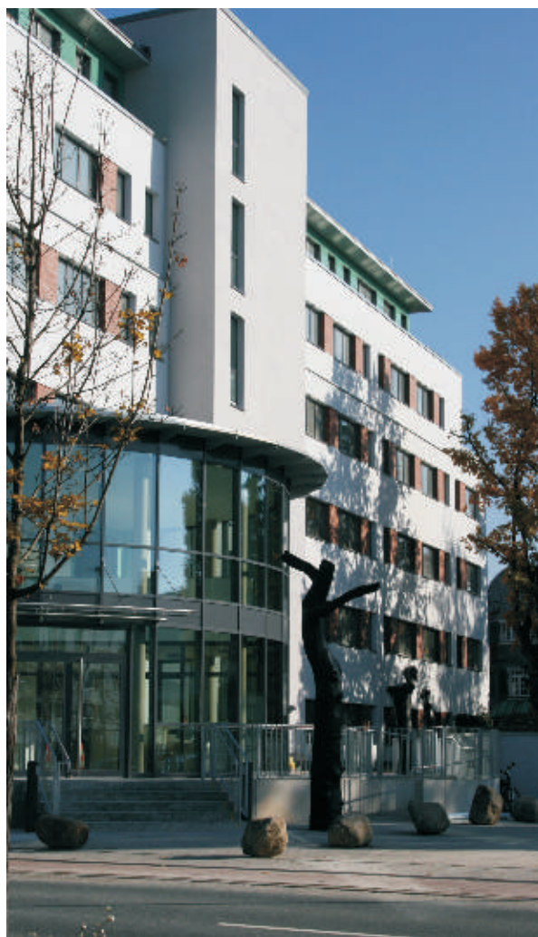
Bürogebäude FORUM* in Erlangen, optimale energetische Generalsanierung, Fa. MAUSS-BAU ERLANGEN
