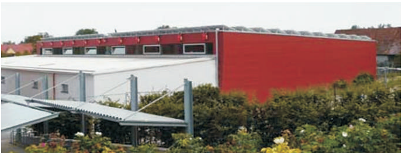
Neubau Dreifachturnhalle in Passivbauweise in Herrieden / Landkreis Ansbach (Quelle: ING + ARCH, Ehingen)
